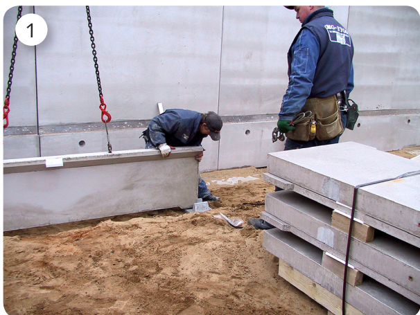
1 Elementet monteres i de utsatte fundamentene.
