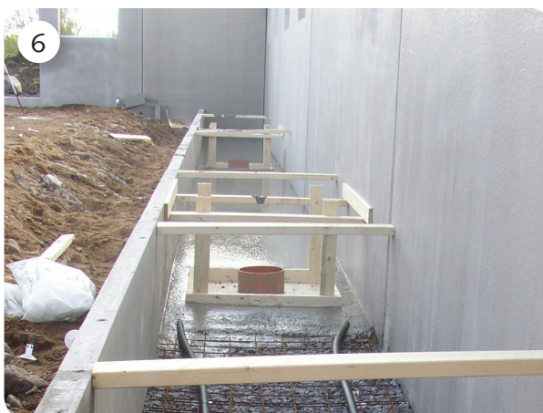
6 Når samtlige rennvegger er montert, støpes bunnen i gødselrennen. Elementene må stages innen tilbakefylling og komprimering gjøres.
