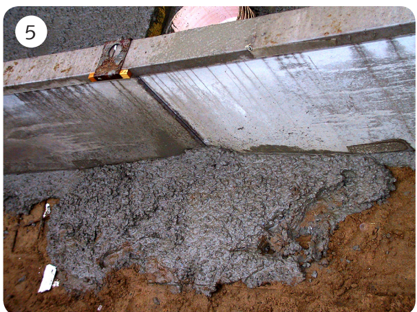
5 På grunn av elementes utforming, faststøpes elementet i samtidig med rennestøpingen.
