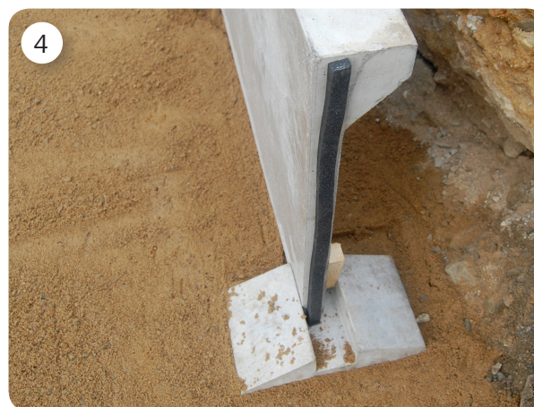
4 1 st tettelist monteres i skjøten mellom elementsidene
