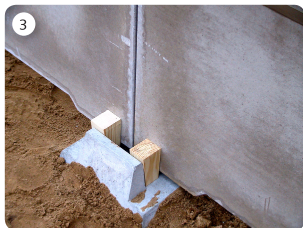
3 Rennveggene kiles fast i fundamenten.
