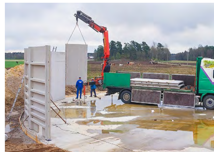
Montaget av behållarväggar går snabbt och utförs i normalfallet med lastbil med kran placerad på bottenplattan.
