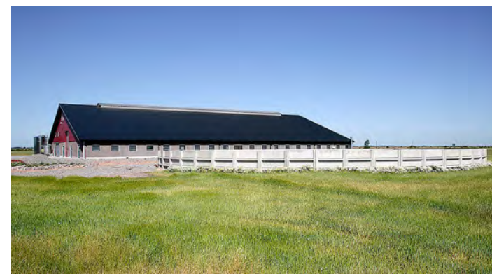
Abetongs gödselbrunnar smälter på ett fint sätt in i omgivningarna.
