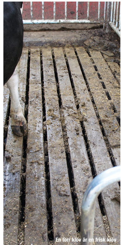
Utgödslingen ligger väl skyddad under spaltgolvet och utgör inget störningsmoment för korna.
